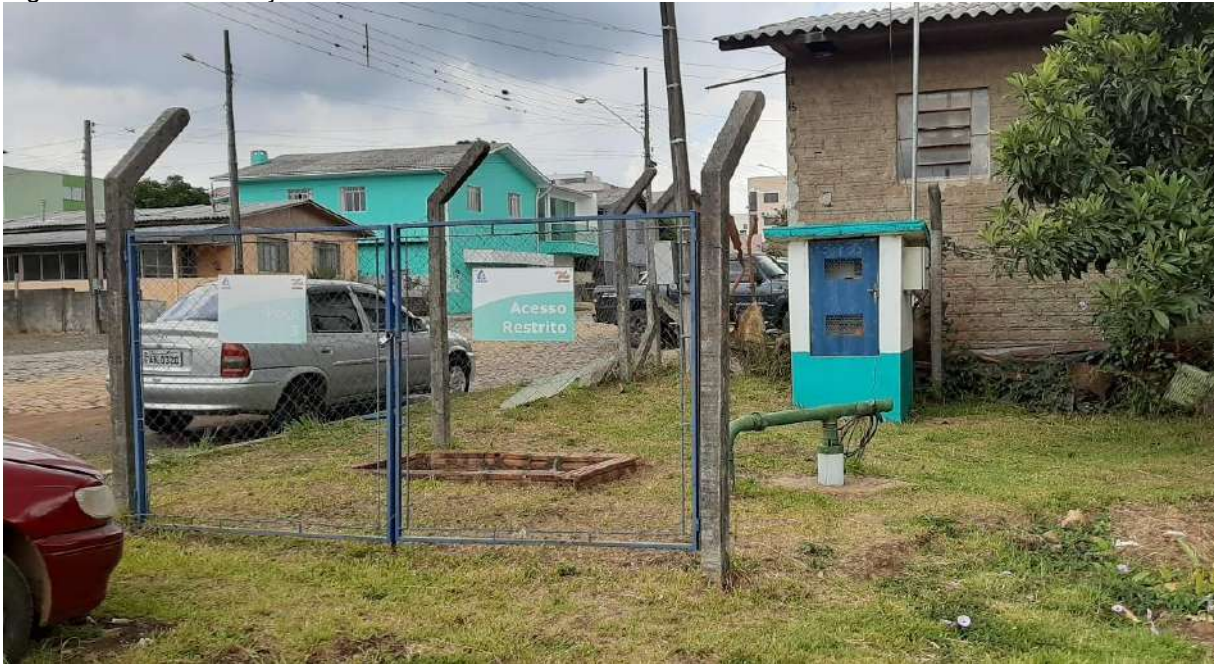
Figura 34: Área do Poço 03.
