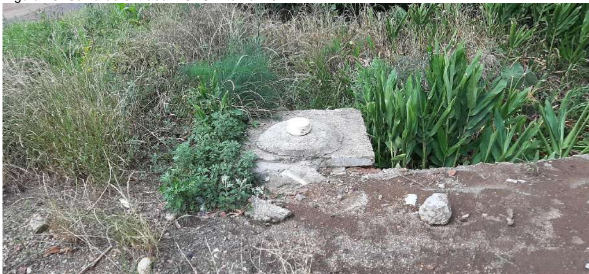
Figura 78: Caixa de entrada – SES Alto Irani 01.
