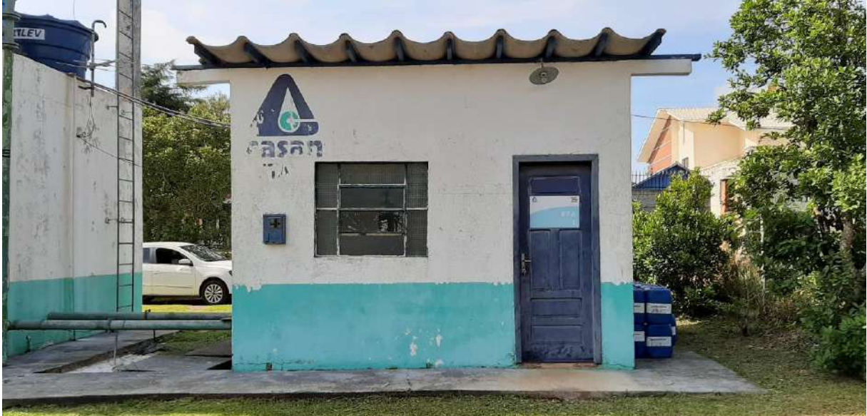
Figura 40: Unidade de tratamento simplificado - ETA 01
