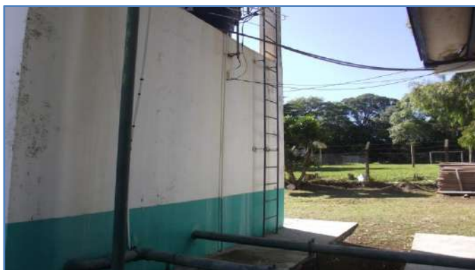
Imagem 45: Escada de acesso.
