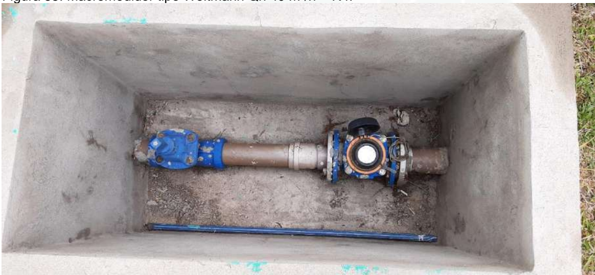
Figura 55: Macromedidor tipo Woltmann Qn 40 m 3 /h – R4.
