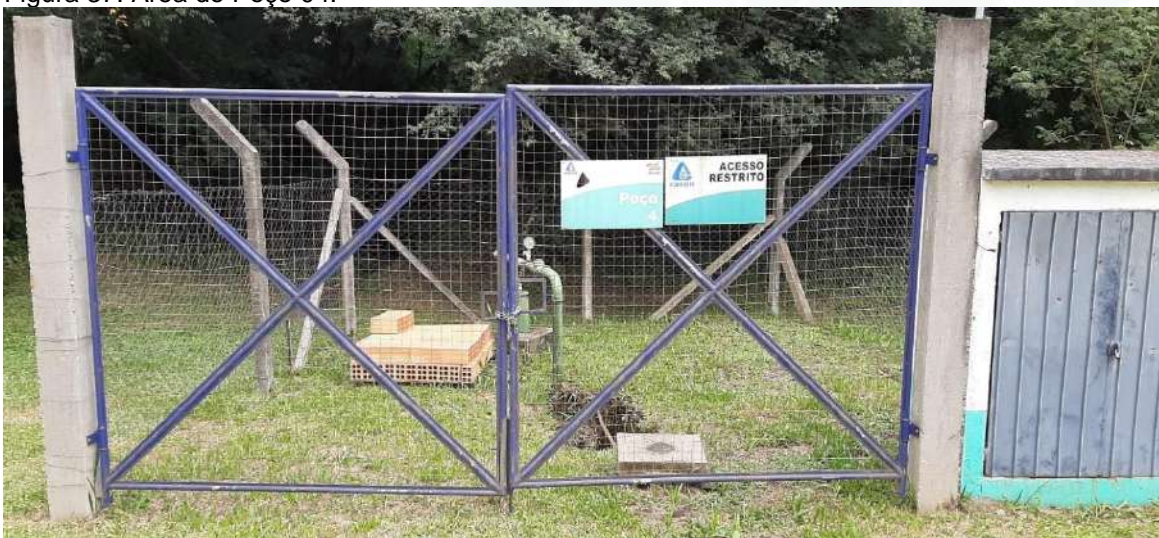
Figura 37: Área do Poço 04.
