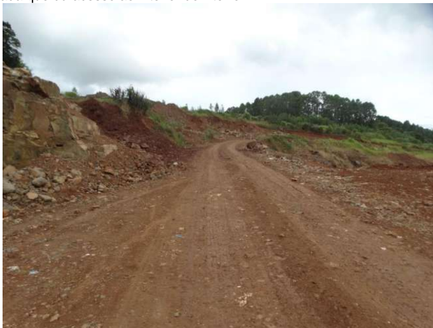
Figura 94: Estrada que dá acesso ao interior do Aterro.
