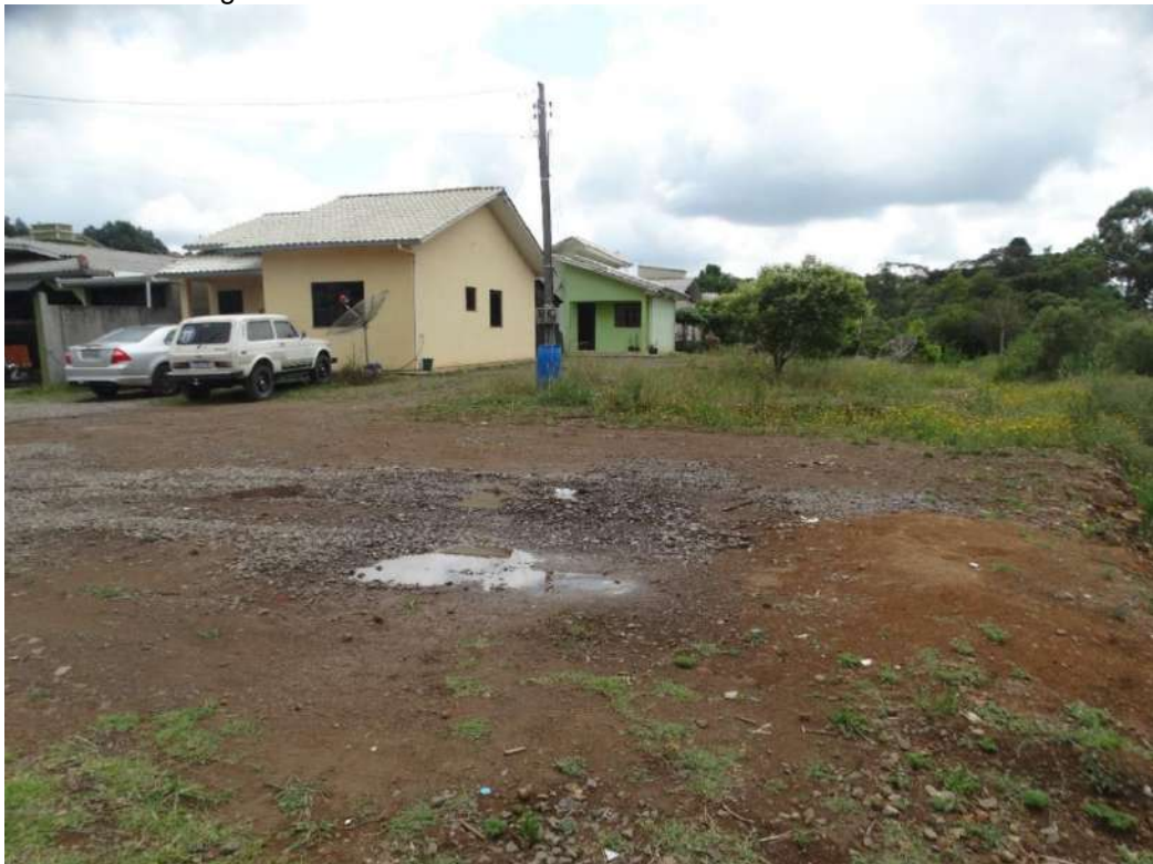
Figura 161: Área de alagamento na AP-07.
