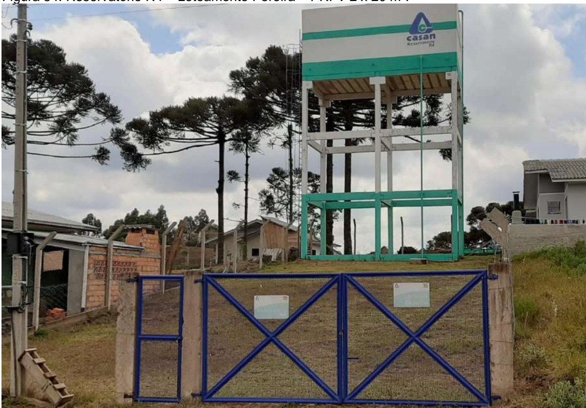
Figura 54: Reservatório R4 – Loteamento Pereira – PRFV 2 x 20 m 3 .
