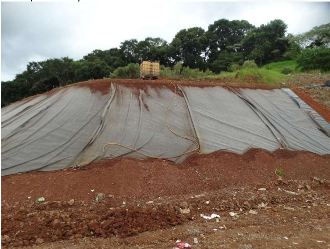
Figura 99: Impermeabilização da célula encerrada com PEBD.
