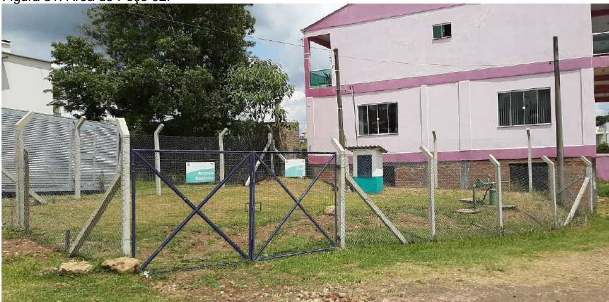
Figura 31: Área do Poço 02.
