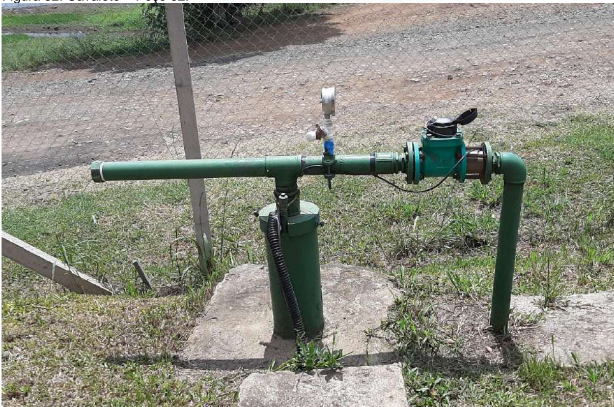
Figura 32: Cavalete – Poço 02.
