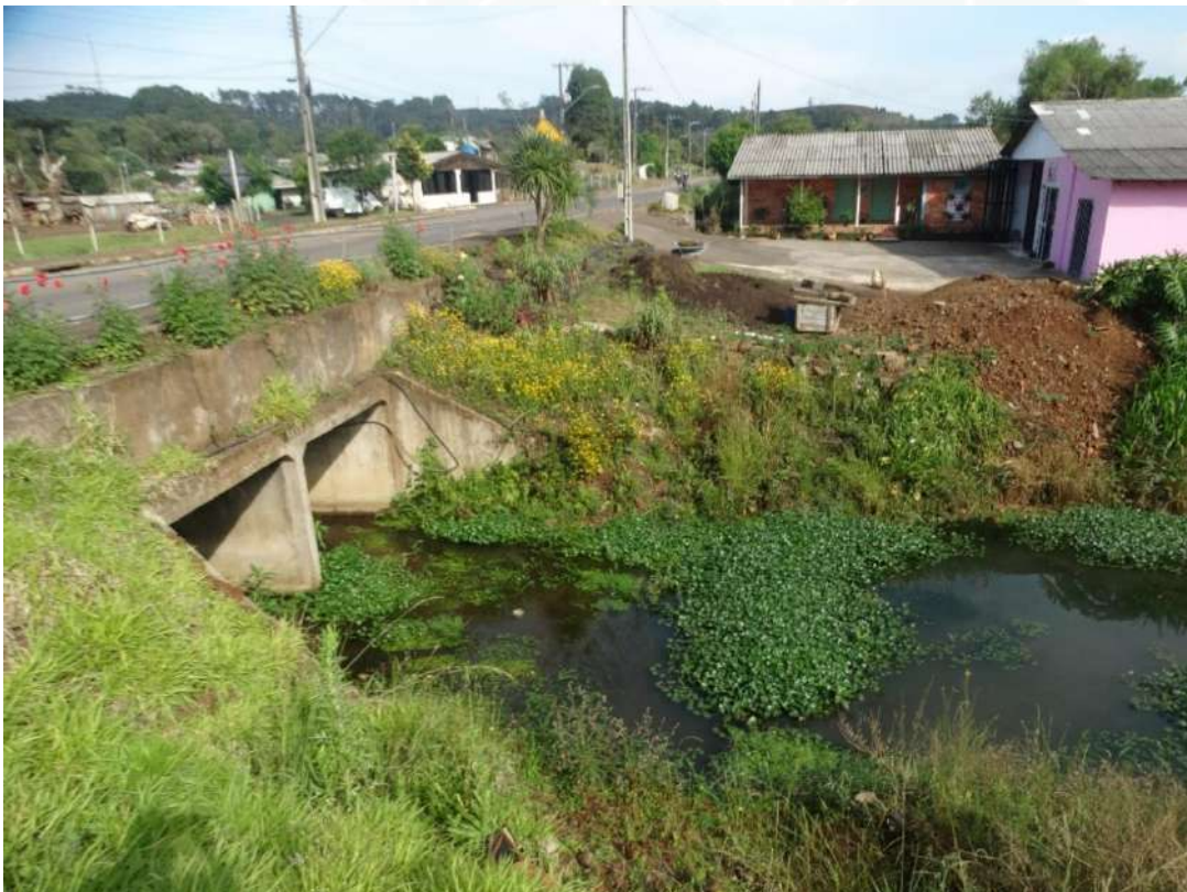
Figura 145: Galeria instalada há cerca de dois anos na AP-02.
