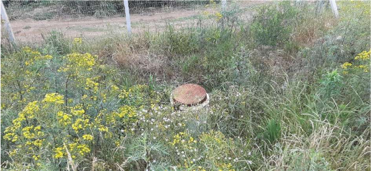
Figura 71: Entorno das unidades de tratamento.
