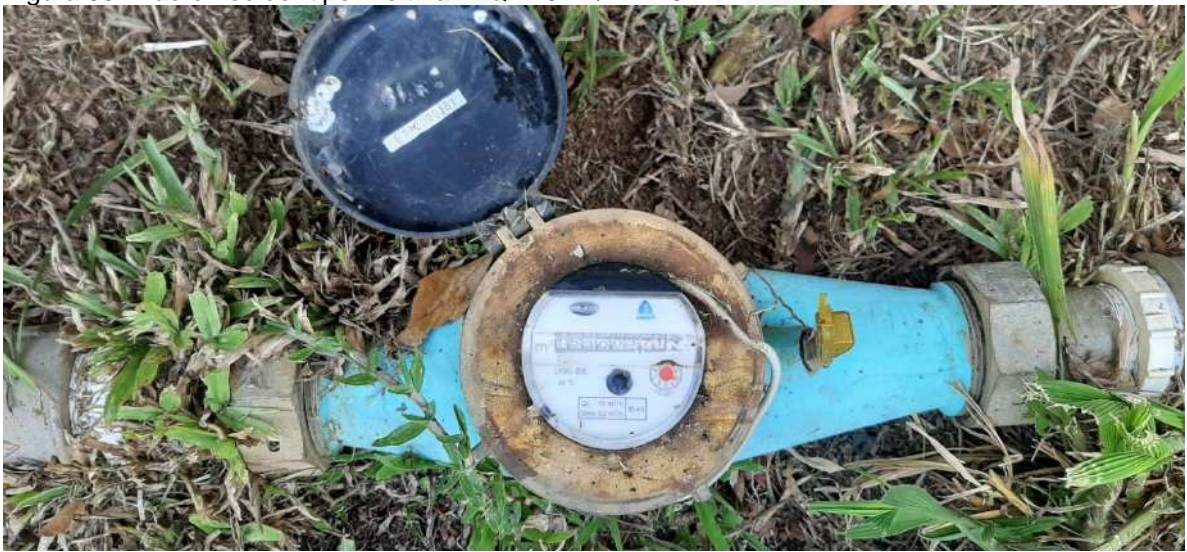
Figura 53: Macromedidor tipo Woltmann Qn 10 m³/h – R3
