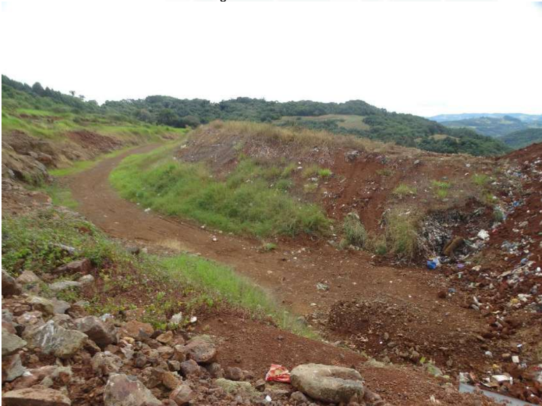
Figura 103: Ausência de sistema de drenagem.
