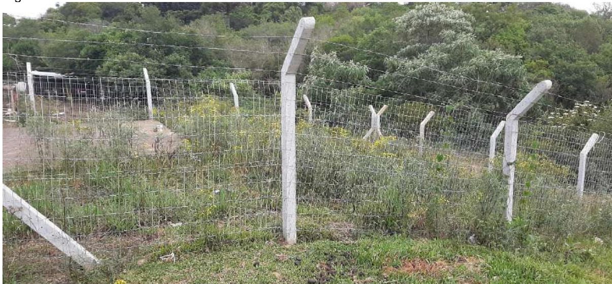
Figura 70: Entorno das unidades de tratamento.
