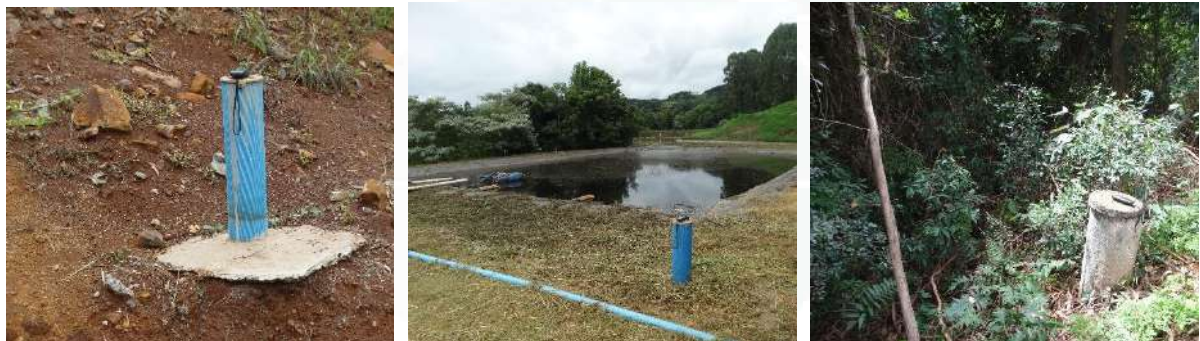
Figura 108: Poços de monitoramento instalados na área do aterro.
