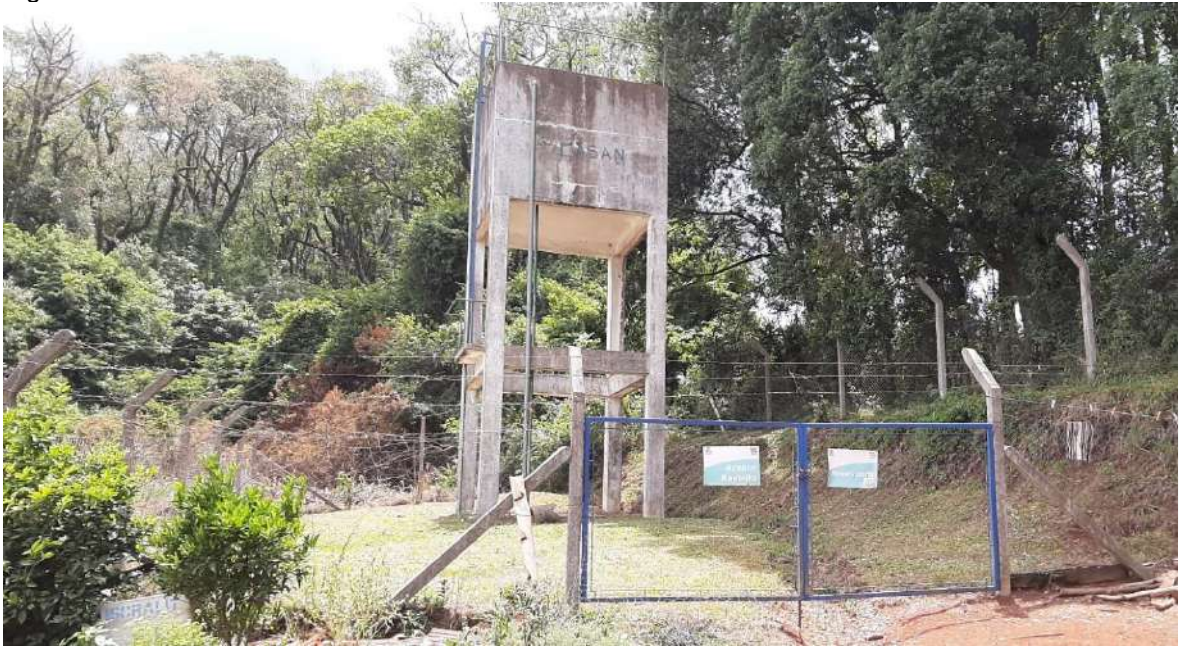
Figura 52: Reservatório R3 – bairro Santo Antônio/COHAB.
