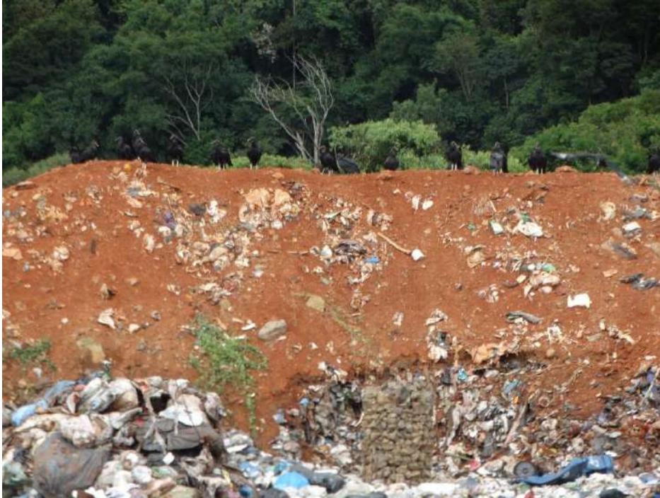
Figura 104: Presença de dreno de biogás.
