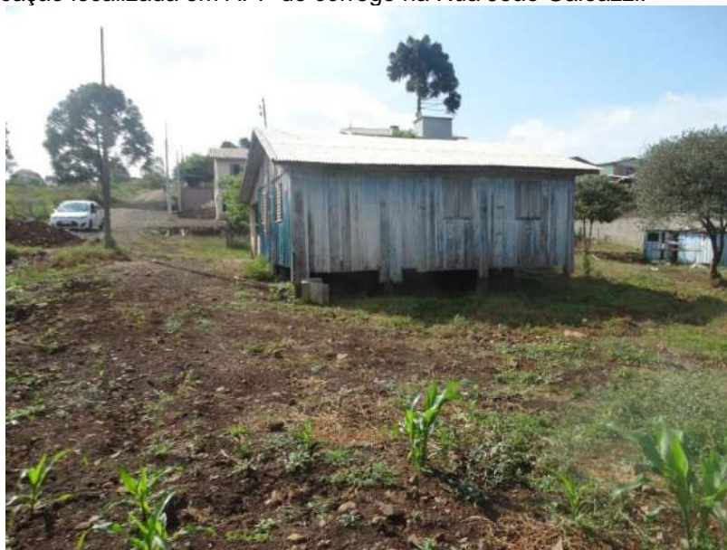
Figura 149: Edificação localizada em APP do córrego na Rua João Galeazzi.
