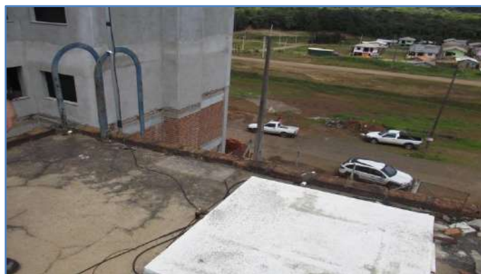
Imagem 62: Tampa de inspeção.
