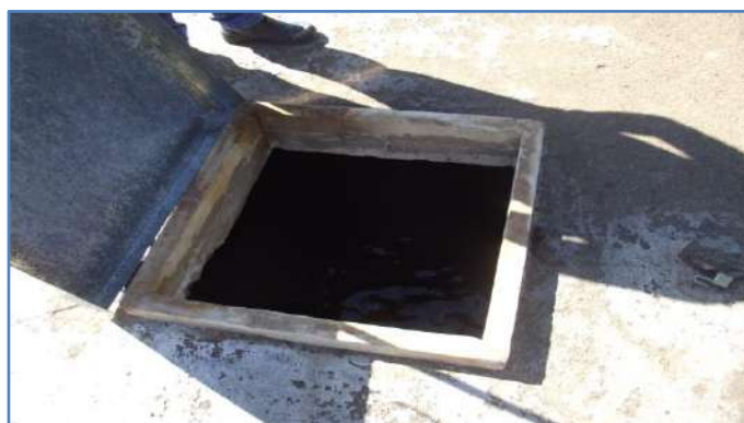
Imagem 48: Tampa de inspeção.
