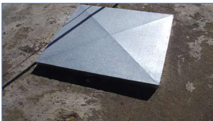
Imagem 47: Tampa de inspeção.
