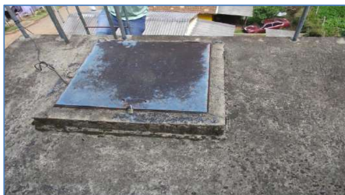
Imagem 54: Tampa de inspeção.
