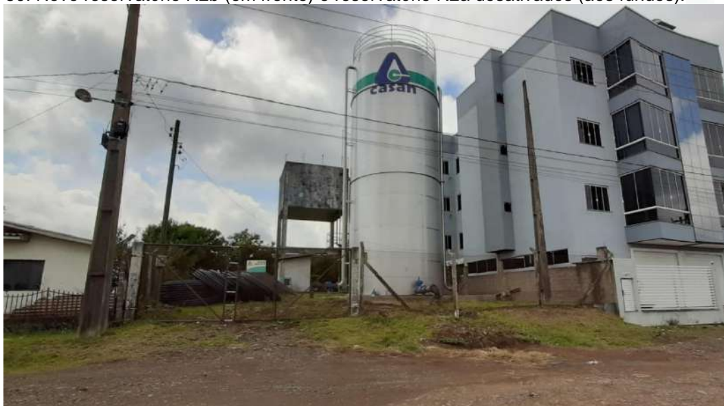
Figura 50: Novo reservatório R2b (em frente) e reservatório R2a desativados (aos fundos).
