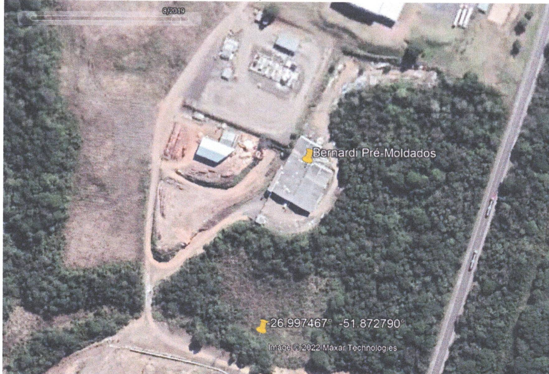
Imagem 4: imagem do local da coordenada fornecida pela RTM. Ano 2019
