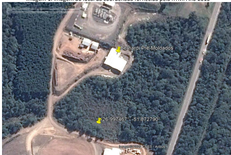
Imagem 1: imagem do local da coordenada fornecida pela RTM. Ano 2013
