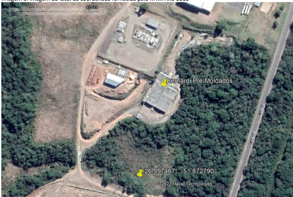
Imagem 3: imagem do local da coordenada fornecida pela RTM. Ano 2018
