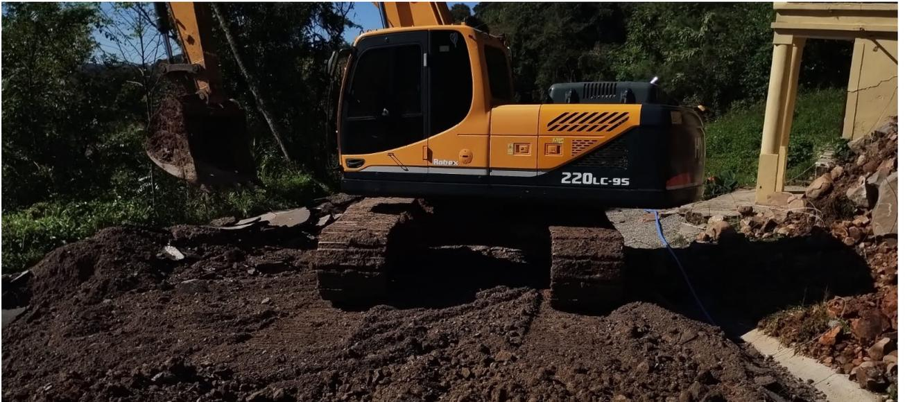
Imagem 5 – Recomposição de talude inferior da estrada da Linha Graciema Alta
