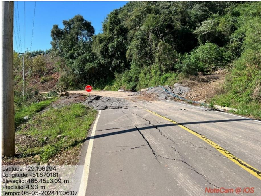
Imagem 3 – Danos à pavimentação asfáltica da Linha Graciema Alta
